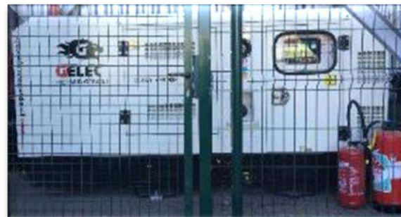
Groupe électrogène de secours : arrêt sécurisé – Démarrage black start Mole iloté en option
